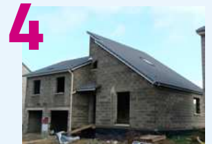
ÉTAPE 4 : Toit et façade
