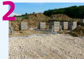
ÉTAPE 2 : Préparation du chantier
