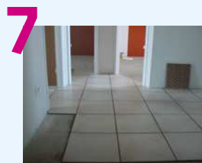
ÉTAPE 7 : Revêtements sols, menuiseries, plafond
