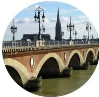
Pont de pierre à Bordeaux
